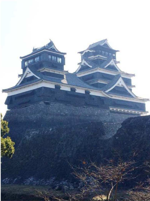
→石垣が大きく崩れた熊本城
